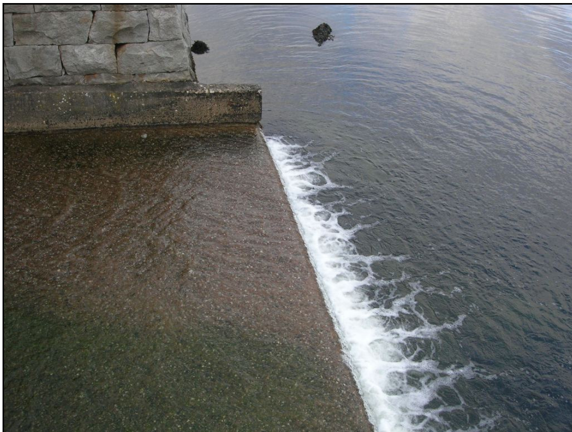
Figur 11. Utløpet til sjøen er utformet som en jevn kant, som virker som et vandringshinder for både ål og sjøørret ved middels og lave vannstander. Sjøørretsmolt vil heller ikke vandre ut over så lavt vannnivå.
